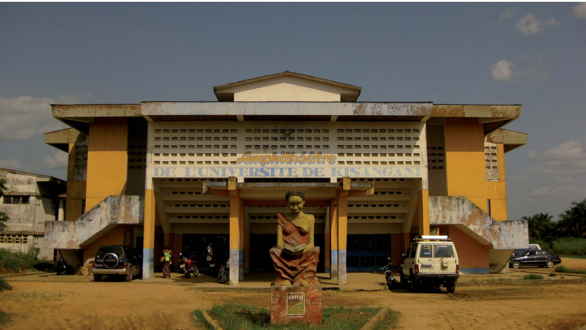
fig. 2.35 - Centrale aula/ amphitheater van de UNIKIS - collectie veldwerk
